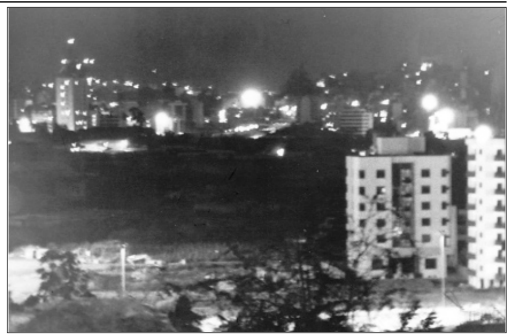
بيروت غرقت في الظلام اثر الانفجار في المحطة. (مجموع الطويل)
