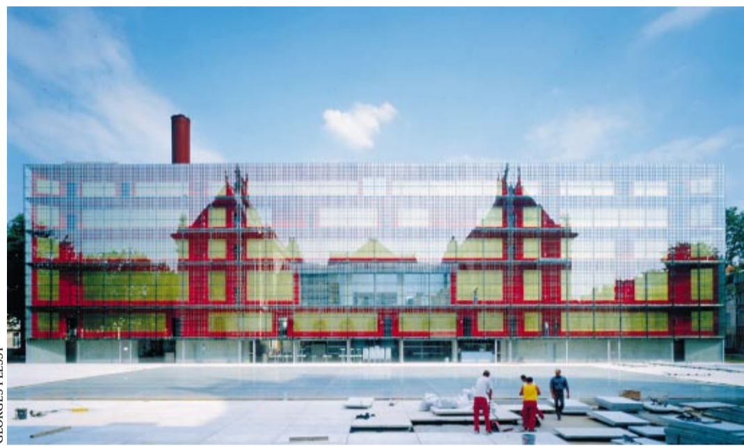
La préfecture se reflète sur la paroi du Palais des beaux-arts. La cheminée de la chaufferie n'est pas un « signal », elle devrait disparaître. Architectes : Jean-Marc Ibos et Myrto Vitart.
