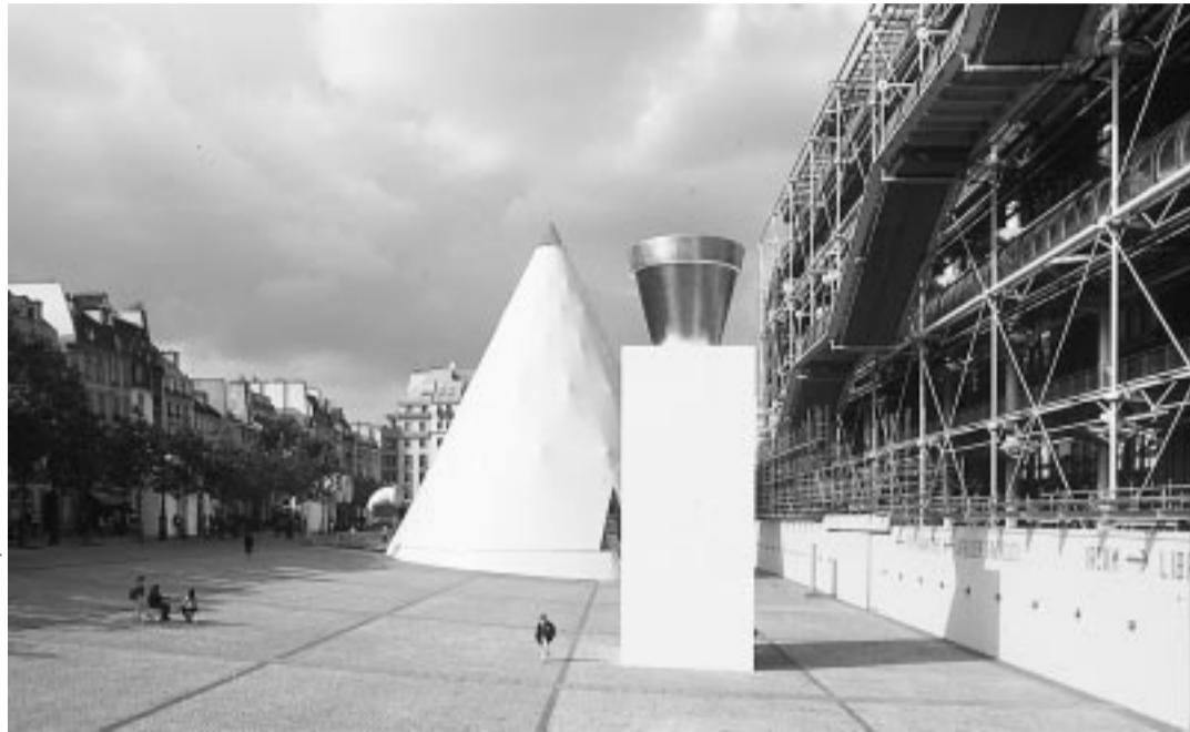
Sur la « piazza », le « Pot doré » de Jean-Pierre Raynaud installé en 1998, et le tipi dressé pour la durée des travaux.
