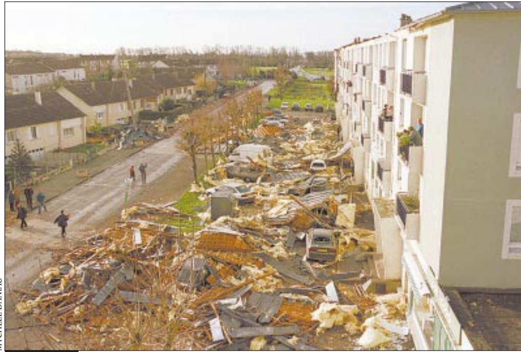
APRÈS Après le passage de la première tempête, la toiture de l'immeuble a été littéralement soufflée. Les voitures sur le parking sont ensevelies sous les gravats.
