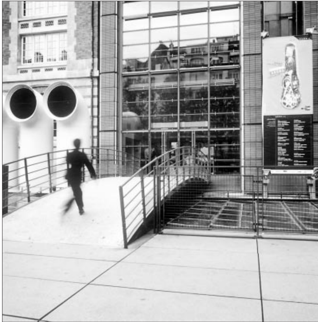
La passerelle du bâtiment de l'Ircam jouxtant le Centre Georges-Pompidou, à Paris.
