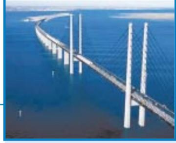
Ouvrage total de 16 km de long dont : Un tunnel de 4 050 m + une île artificielle de 4 055 m + un pont de 8 000 m
