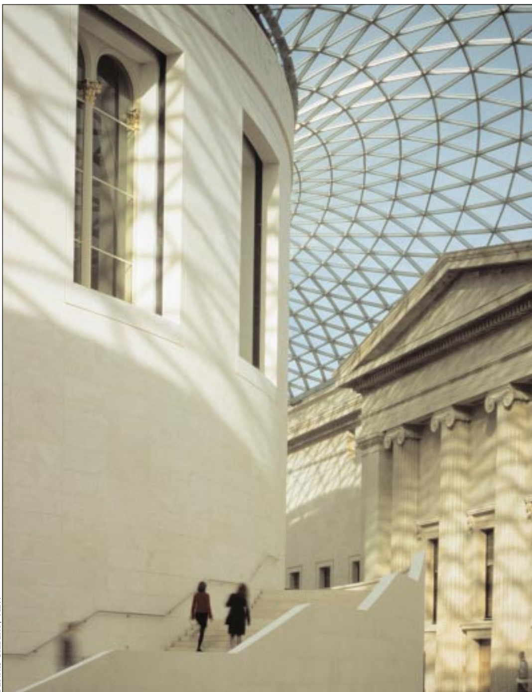
Tous différents, les panneaux de la verrière paraissent pourtant réguliers, grâce à l'informatique.
