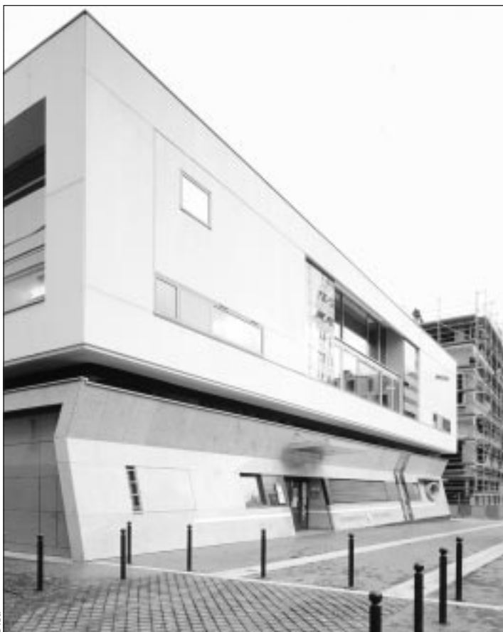
L'école maternelle de la ZAC de la Moskowa (Paris-18 e ). Un volume solide et opaque, percé de larges baies lumineuses.
