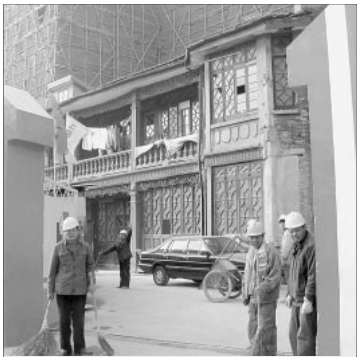
Chantier dans le quartier de Luwan, à Puxi, la partie occidentale de Shanghai.
