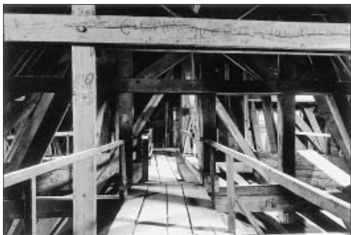
La charpente de la nef qui n'est pas accessible au public pour des raisons de sécurité.
