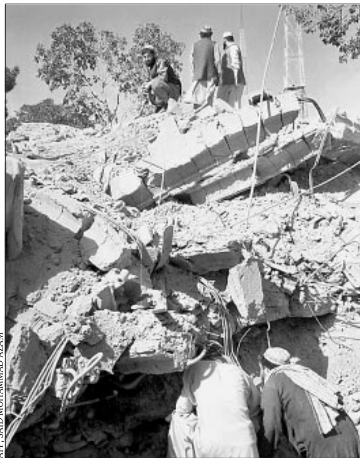
■ AFGHANISTAN. Deux Afghans à la recherche des corps dans les débris d'une agence de l'ONU chargée du déminage, frappée mardi 9 octobre par un missile de croisière américain. Cet immeuble de deux étages abritait les bureaux d'afghan technical consultants (ATC), à une dizaine de kilomètres à l'est de Kaboul. Bilan : quatre morts.
