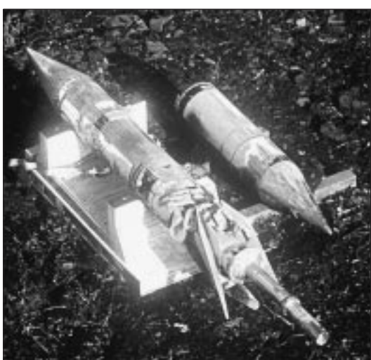
Le bombardier B2 largue une bombe B61-11, sans charge nucléaire, lors d'une campagne d'essais en 1998, en Alaska (en haut). Les engins testés ont pénétré le sol de plusieurs mètres. On les voit, ci-dessus, excavés.
