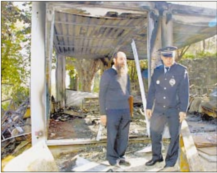
Un rabbin de la communauté juive de Marseille, accompagné d'un policier, découvre, le 29 octobre 2001, les dégâts causés la veille par un incendie perpétré contre deux bâtiments préfabriqués de l'école confessionnelle juive Gan Pardes, dans les quartiers Nord de la ville. Des slogans « Ben Laden vaincra » et « Mort aux juifs » ont été inscrits sur les murs du bâtiment principal.
