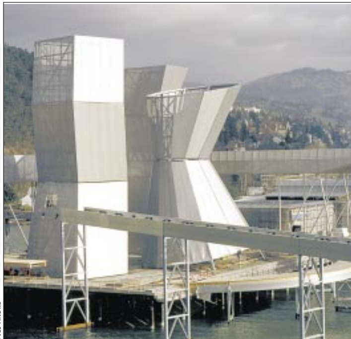
A Biel-Bienne, les trois tours, symboles du pouvoir, réalisées par les architectes de l'agence autrichienne Coop-Himmelblau.
