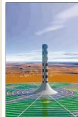
LE PROJET de Tour solaire de 1 km de haut lancé en Australie pourrait conduire à la réalisation de la plus haute construction du monde. Conçu par des architectes allemands, le système, exploitant la différence de densité entre l'air chaud et l'air froid, atteindrait une puissance de 200 MW. Pas moins de 5 km<sup>2</sup> seront couverts par une surface vitrée qui portera l'air à 30 degrés. Aspiré par la cheminée géante, il entraînera 32 turbines qui produiront une électricité propre.
